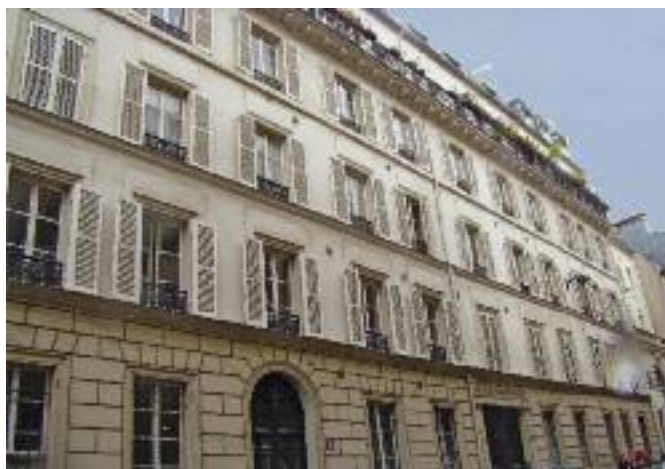
Façade sur rue en enduit de plâtre revêtu
