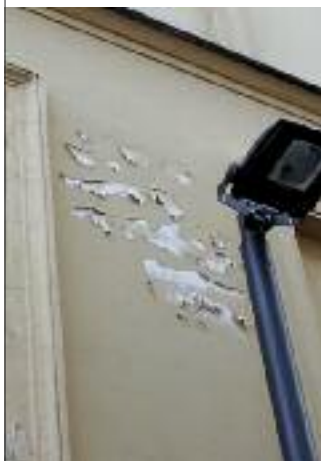
Décollement et cloquage de revêtement sur enduit de plâtre
