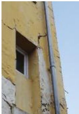
Décollement et cloquage de revêtement sur enduit de plâtre
